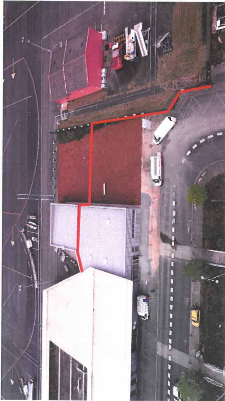
Vue (drone) des bâtiments (aérogare + extension), avec la limite ZCV – ZCP (trait rouge)
