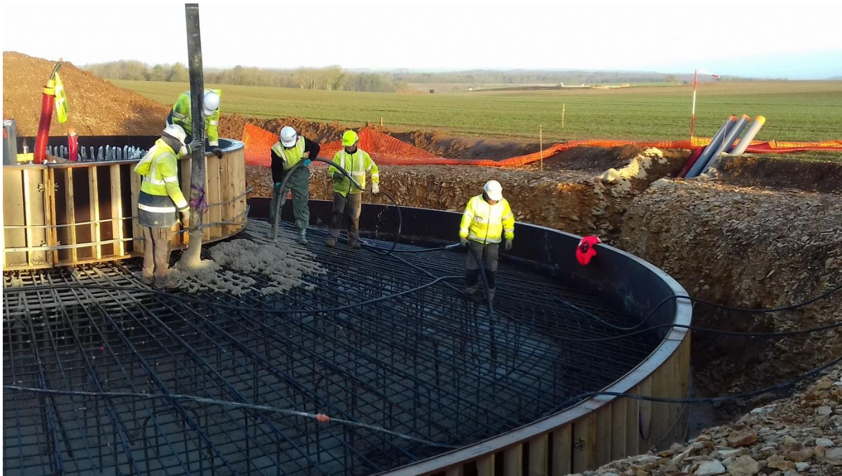
Coulage du béton d'une fondation
