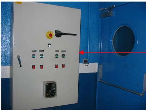
b. Mettre à l'arrêt les pompes et les ventilateurs :
