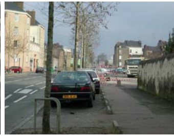
3 : Travaux sur le trottoir
