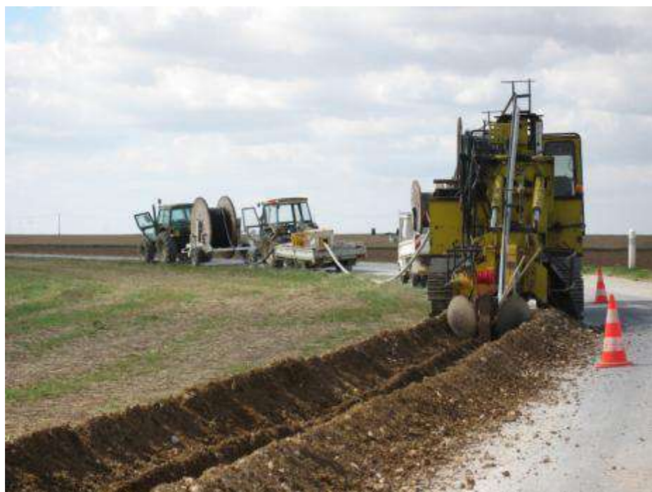
Figure 138 : Illustration des travaux de raccordement (source : EDF Renouvelables)
