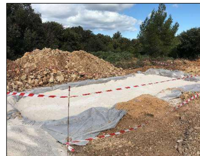
Figure 47 : Fouille préparée pour la pose d'un poste de conversion/transformation (Source : EDF Renouvelables)
