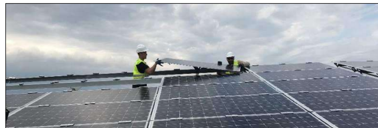
Figure 45 : Pose des modules (Source : EDF RENEUVELABLES)
