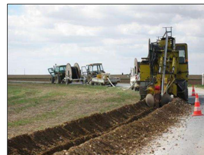
Figure 48 : Réalisation de tranchées du raccordement externe dans l'emprise des voies existantes (Source : EDF Renouvelables)
