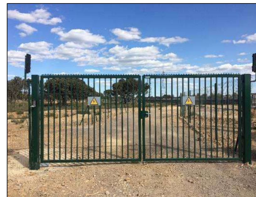
Figure 37 : Exemple de portail (Source : EDF RENOUELABLES)
