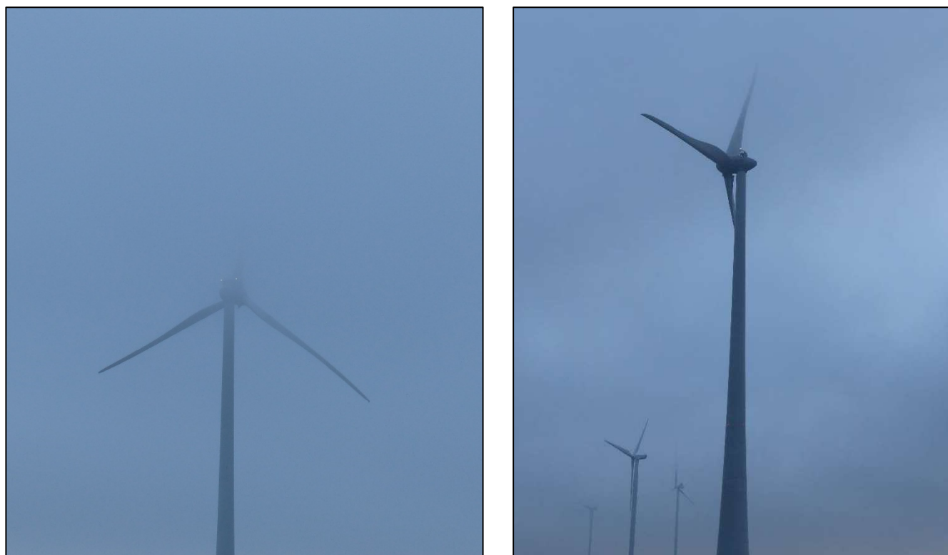
Photographie 11 : Exemple de situation à risque : brouillard en hauteur masquant tout ou partie des pales.
