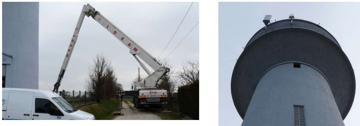
Figure 86 : Installation d'un réémetteur sur un château d'eau
