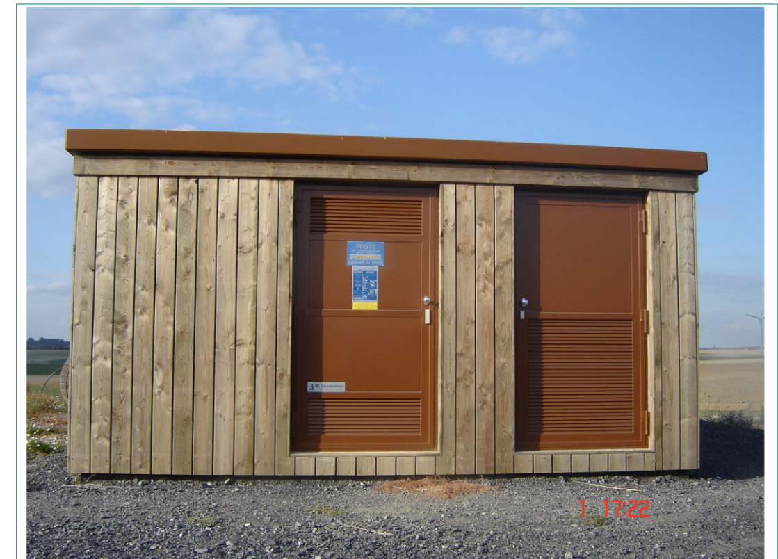
Exemple d'un poste de livraison présentant un bardage bois vertical
