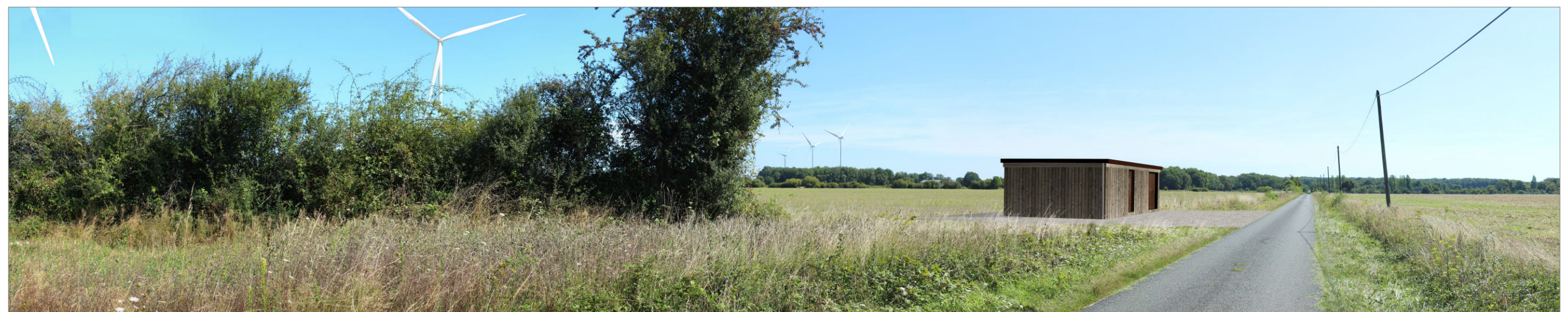
Photomontage du poste de livraison 1 réalisé par le bureau d'étude ABIÉS pour le projet éolien de Chenevelles (86)
