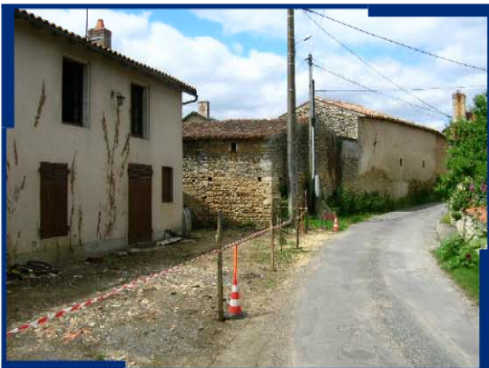
29 : "Brossac" : limite de zone inondable rive droite dans le virage au niveau du poteau
