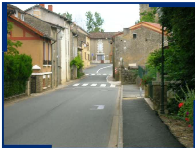
40 : "Château-Larcher" : limite de zone inondable rive droite au niveau du second passage piéton
