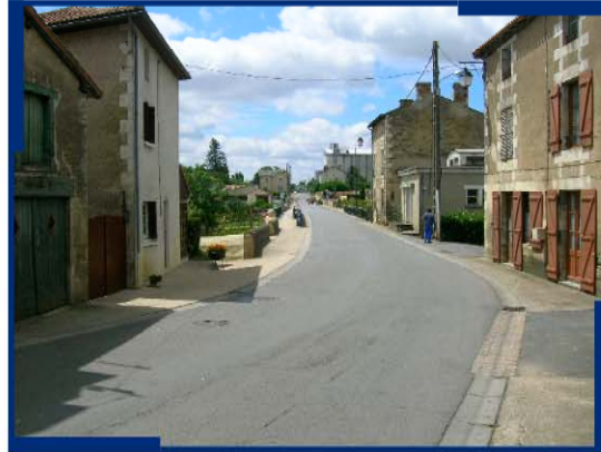
20 : "Usson-du-Poitou" : vue globale de la zone inondable depuis son extrémité en rive droite
