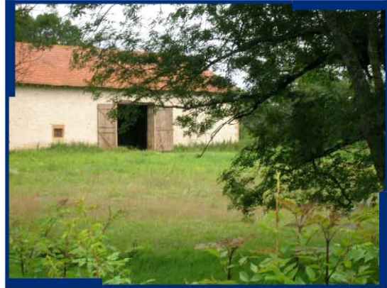
8 : "Badeuil" : limite de la zone inondable en aval du pont en rive gauche arrive en bordure du bâtiment
