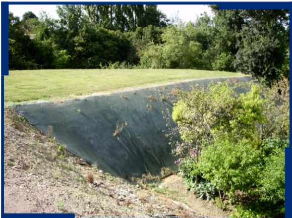
5 : "Lhommaizé" : remblais en aval immédiat rive droite du pont
