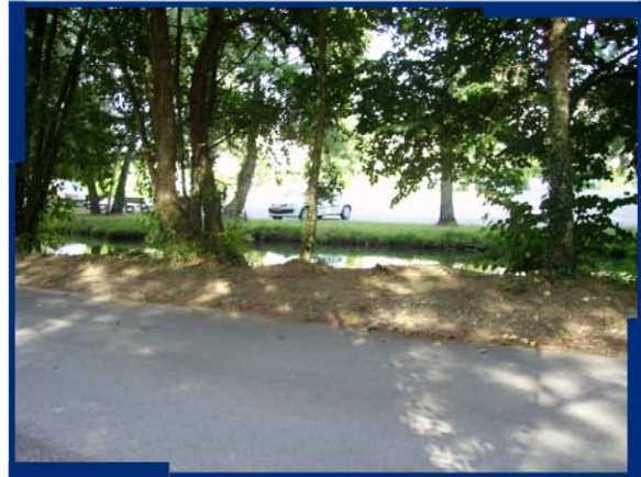
8 : "Morthemer" : vue en amont du pont de la rivière canalisée avec un profil en toit
