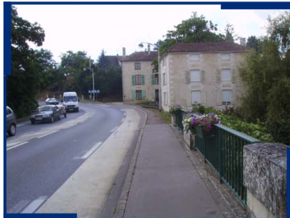
6 : "Lhommaizé" : limite de zone inondable en rive gauche après la première maison située à droite de la photo
