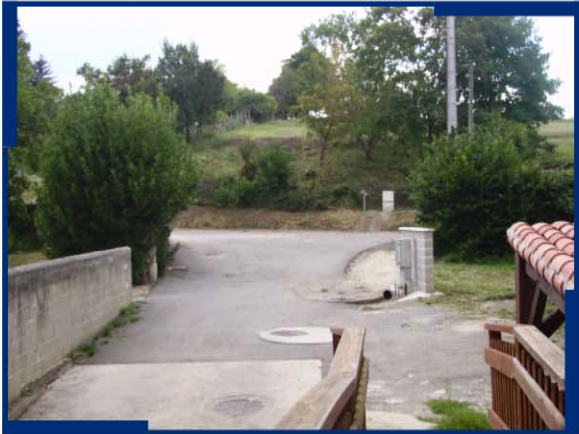
7 : "Lhonnaizé" : la limite de zone inondable rive gauche en aval du pont arrive au niveau du compteur
