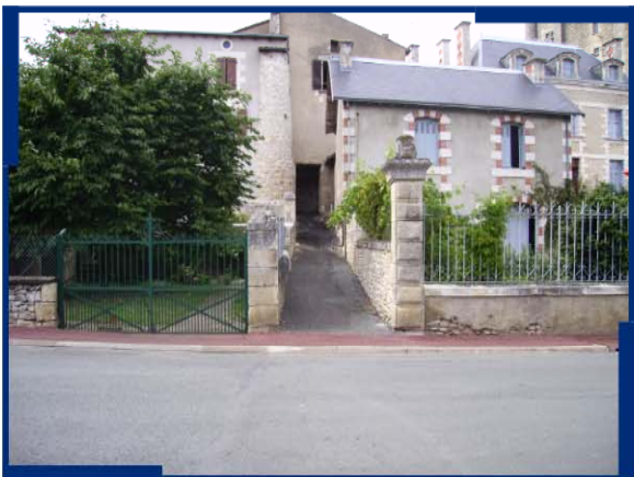
9 : "Morthemer" : la limite de zone inondable rive gauche en aval du pont arrive avant le premier bâtiment à droite du petit chemin
