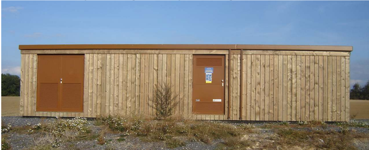
Figure 8 : Exemple de bardage bois sur un poste de livraison
