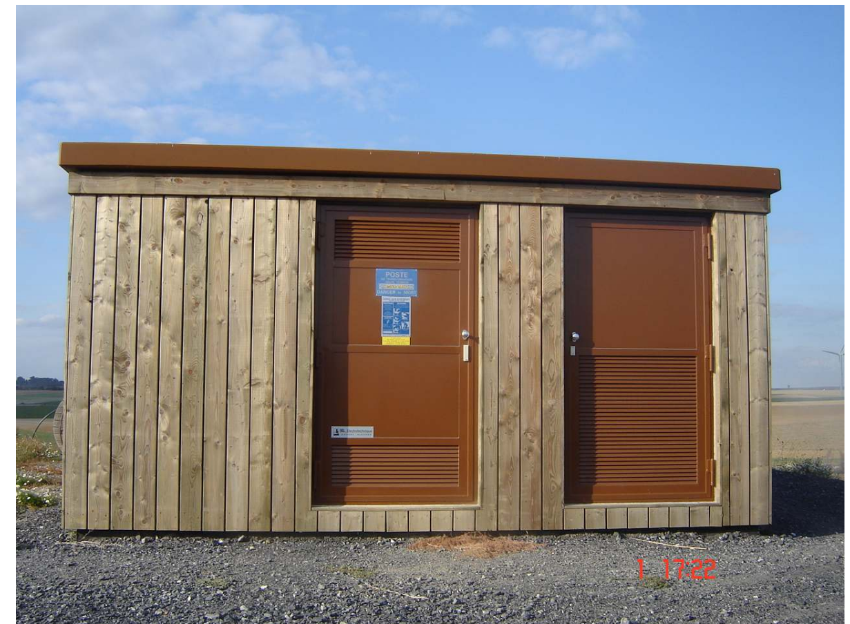
Figure 50 : Exemple de poste de livraison
