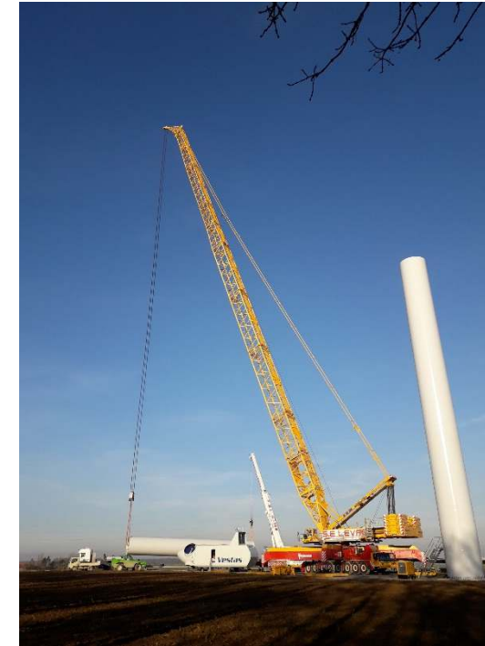
Figure 56 : Grue permettant l'assemblage des différents éléments d'une éolienne (Source : VOLKSWIND)
