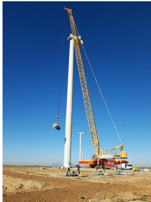
Figure 63 : Montage de la génératrice (Source : VOLKSWIND)
