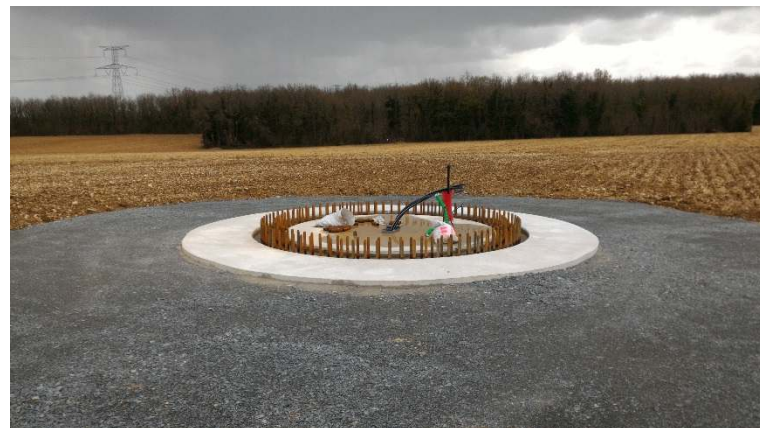
Figure 59 : Fondation finalisée (Source : VOLKSWIND)
