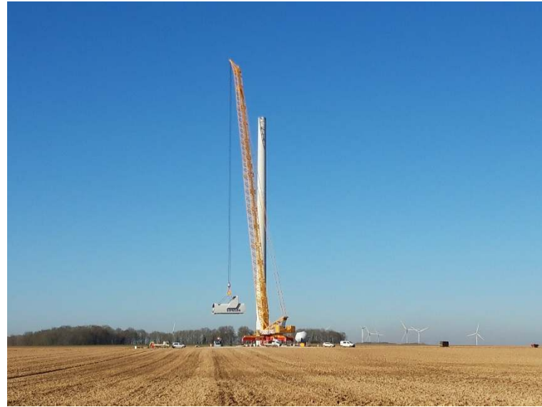
Figure 62 : Montage de la nacelle (Source : VOLKSWIND)
