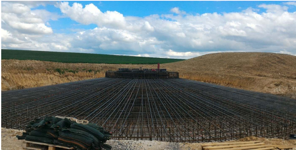
Figure 54 : Ferrailage du massif (Source : VOLKSWIND)
