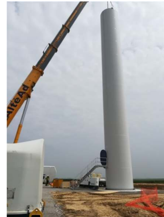
Figure 60 : Montage de la première section du mât (Source : VOLKSWIND)
