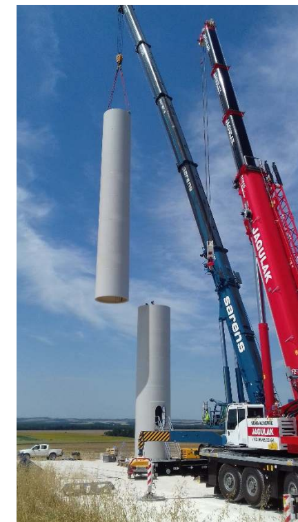
Figure 61 : Montage de la seconde section du mât (Source : VOLKSWIND)
