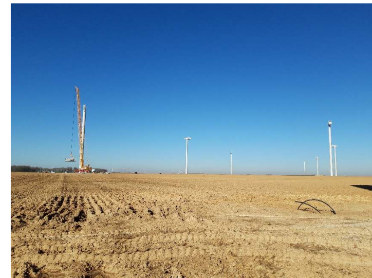
Figure 65 : Un parc de neuf éoliennes Vestas V112 en construction (Source : VOLKSWIND)
