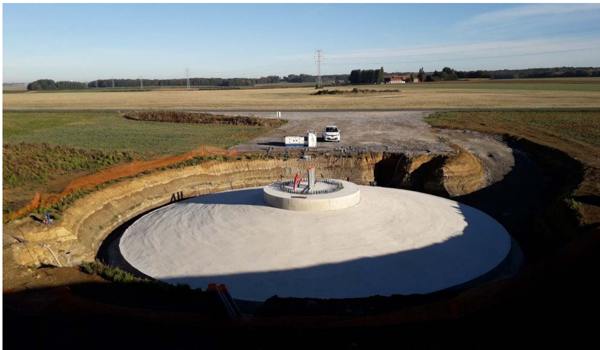
Figure 55 : Fondation après coulage béton (Source : VOLKSWIND)
