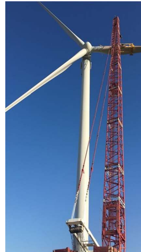
Figure 64 : Montage des pales (Source : VOLKSWIND)
