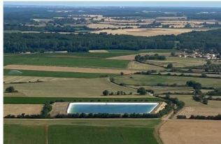
Réserve existante à Château Larcher
