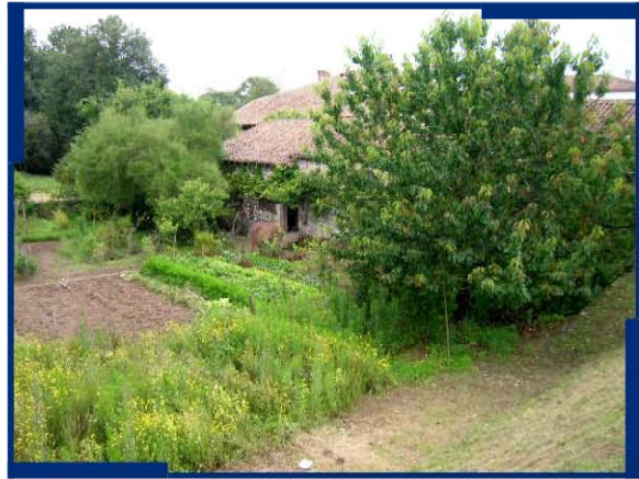
4 : "Oradour-Fanais" : la limite de zone inondable en aval du pont et en rive droite comprend le chemin
