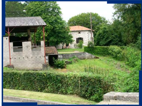
2 : "Oradour-Fanais" : ces bâtiments sont en zone inondable
