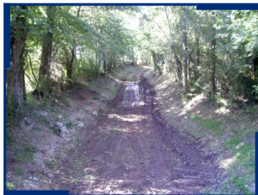
4 : "Les Planches" : vue sur le lit mineur de la Bouleure, totalement recalibré et toujours à sec.
