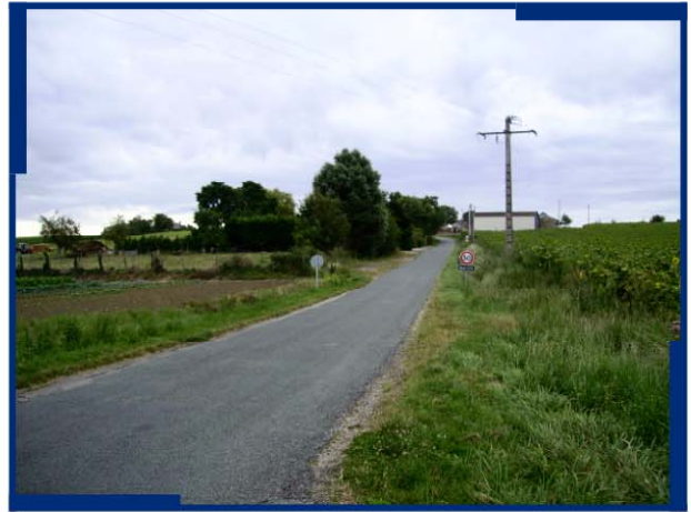
2 : "La Renardière" : limite de zone inondable rive droite au niveau du panneau
