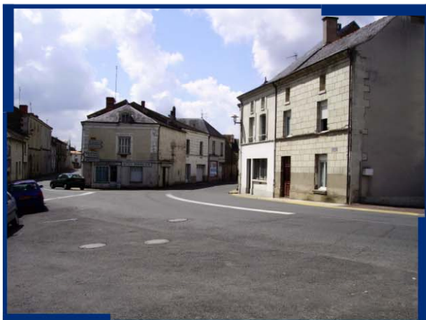
11 : "Lenclôtre" : Agence immobilière au centre de la patte d'olé est en zone inondable
