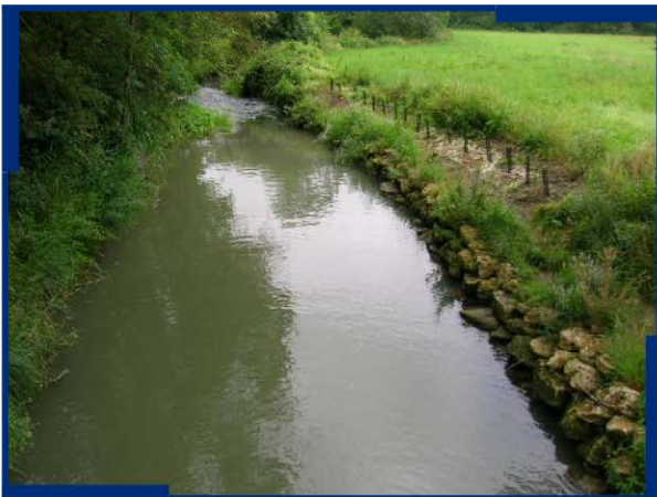
17 : "Le Gué de Landin" : 30 m d'enrochement et de protection végétale sur ce secteur
