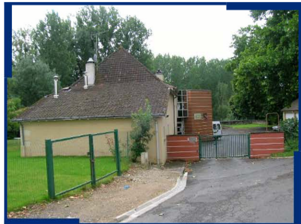
18 : "Le Chillou" : limite de zone inondable rive droite au droit du portail
