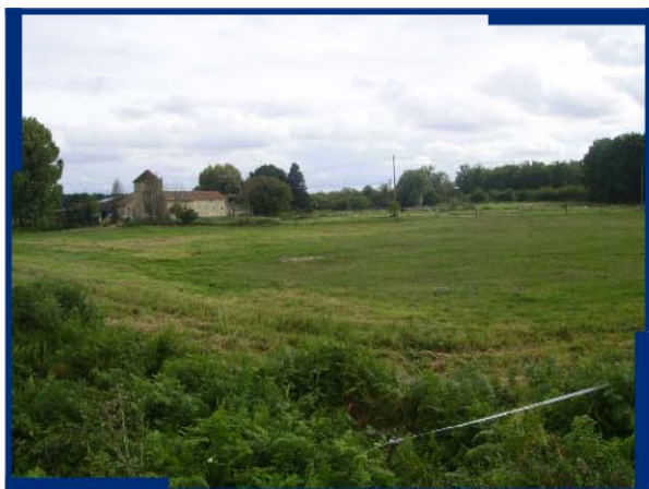
7 : "Mâchefer" : limite de zone inondable en amont de l'ouvrage en rive gauche située le long de la route qui mène au pigeonnier
