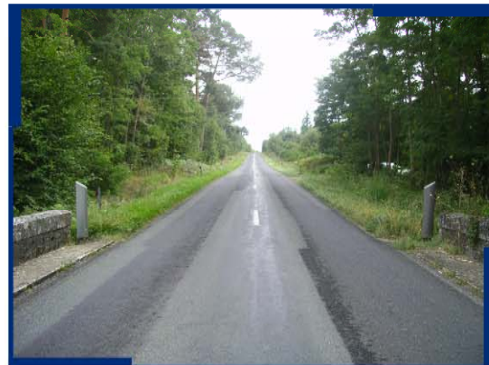
6 : "Le Pont de Reuzé" : limite de zone inondable en rive gauche au niveau de la rupture de pente de la route
