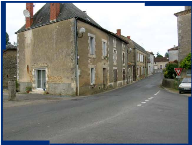
5 : "Mauprévoir" : limite de zone inondable rive droite au niveau du carrefour et du panneau de signalisation
