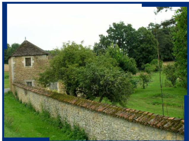
8 : "Payroux" : la limite de zone inondable rive gauche, en amont de l'ouvrage, est située derrière le mur du parc ; le parc du château est donc en zone inondable
