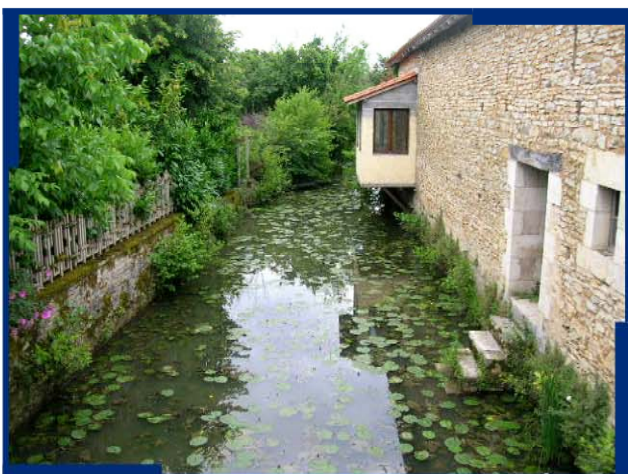
3 : "Mauprévoir" : vue en amont du pont du lit mineur ; la maison à droite de la photo est en zone inondable
