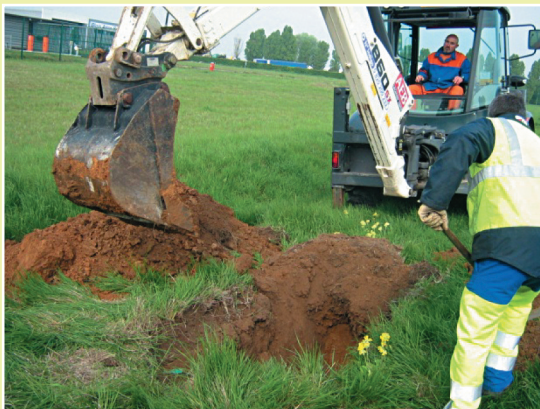
Sondages à la pelle mécanique dans des matériaux limoneux (Source Cerema)
