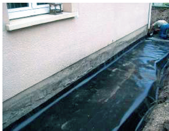
Figure 22 Géomembrane en cours de pose (Source Socabat)
