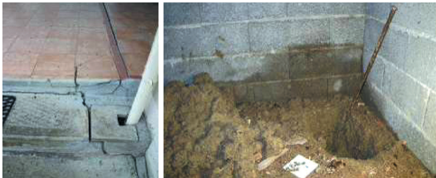
Figure 8 Extérieur (gauche) et intérieur (droite) du vide sanitaire (Source Socabat)
