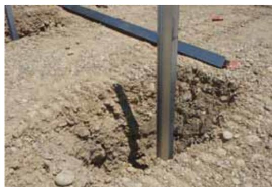
Photo 6 : Exemple de pieux en acier (Source : Guide de l'étude d'impact 2011)
