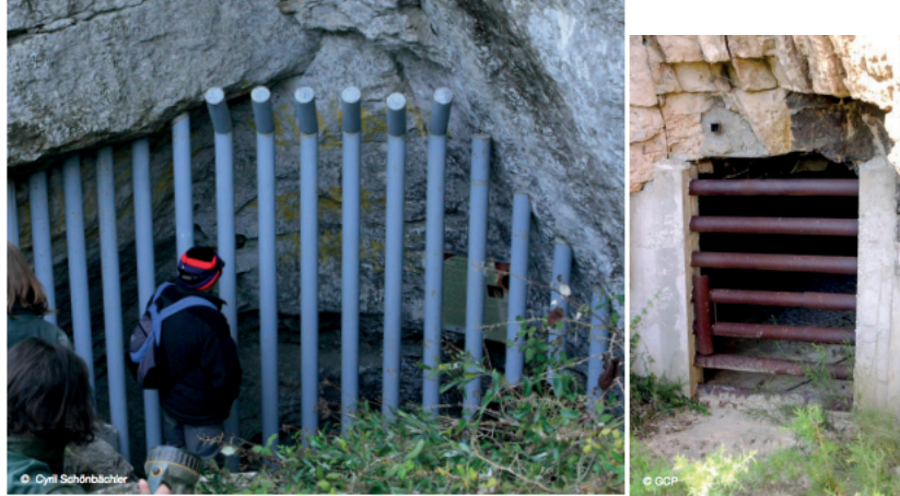
Figure 4 : exemples de protection de cavité à chiroptères
