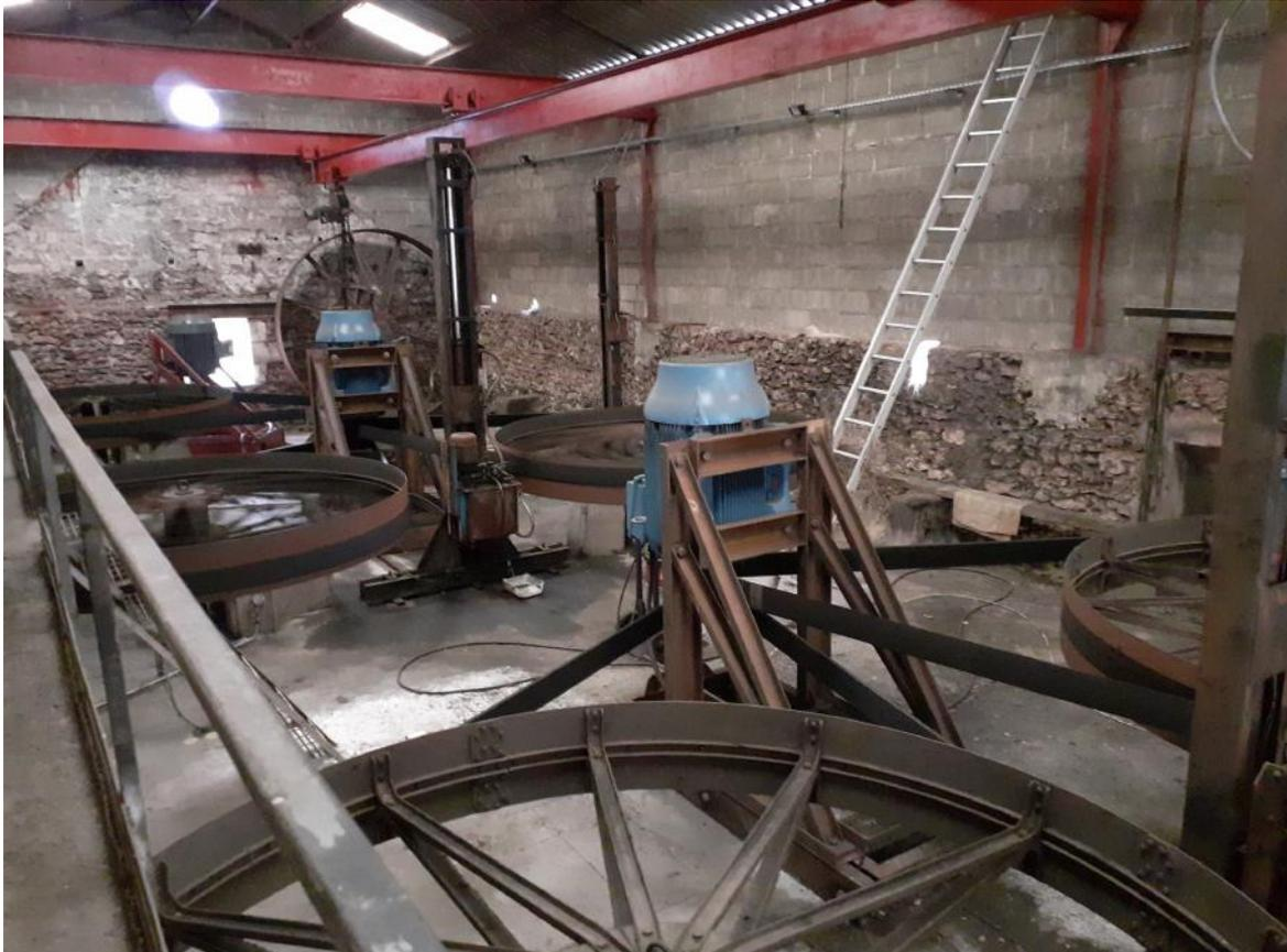
Figure 4 : couplage des turbines aux génératrices électriques
