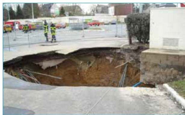
Illustration 1.27 : Effondrement de chaussée, Bapaume (62) [crédit BRGM, sd]
