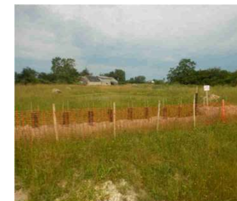
Mise en défens
