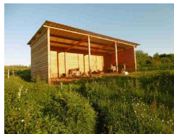
Exemple d'abri léger construit par le futur exploitant
