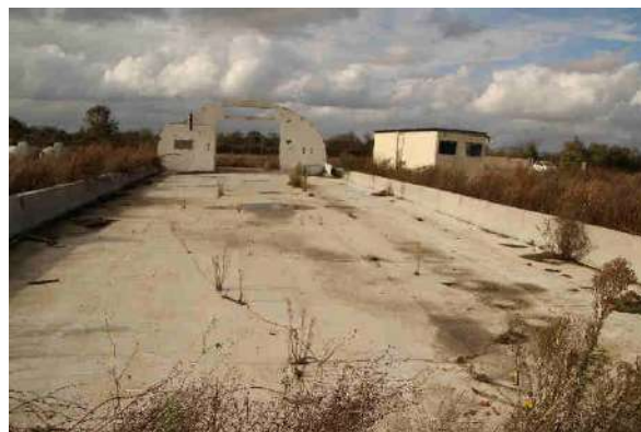
Ensemble de bâtis agricoles
