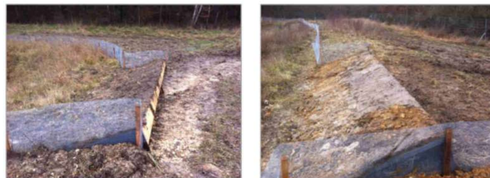
Dispositif d'échappatoire avec la clôture amphibien plaquée
