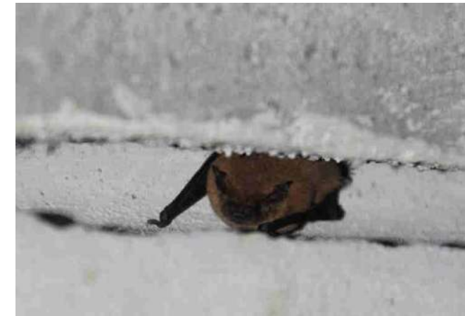
Interstices entre éléments préfabriqués favorables aux chiroptères (©INGEROP)
