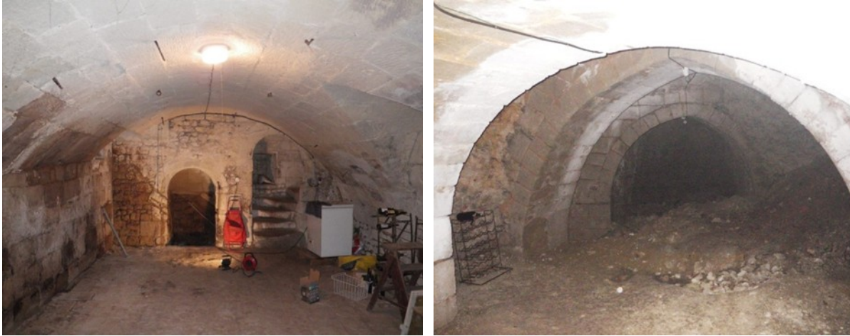
Illustration 5 : cavités du centre-ville parées de pierres de taille et voûtées.
