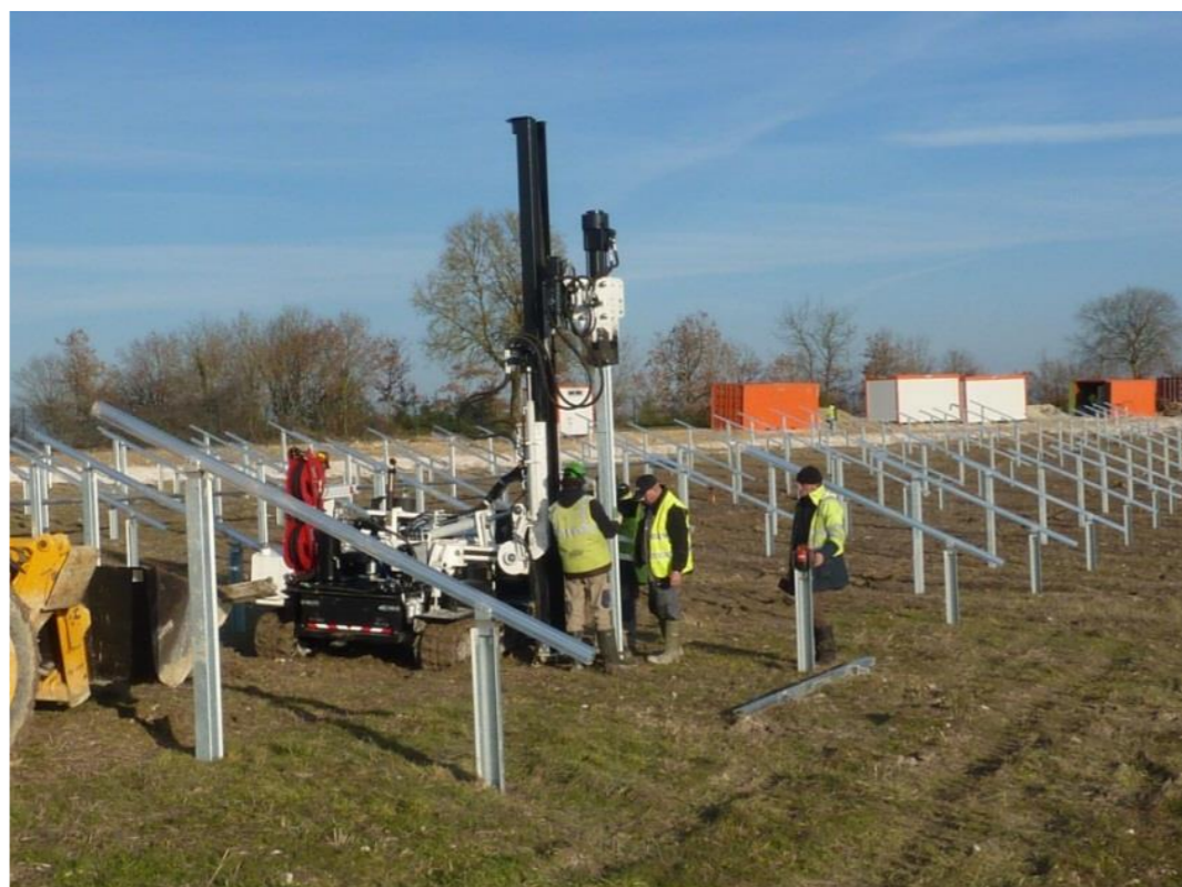
Figure 3 : Mise en place de support de panneaux
