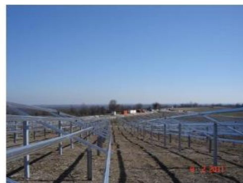
Fixation des rails de support
