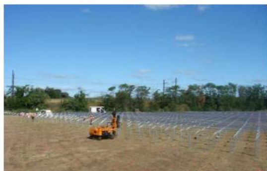
Battage des pieux
