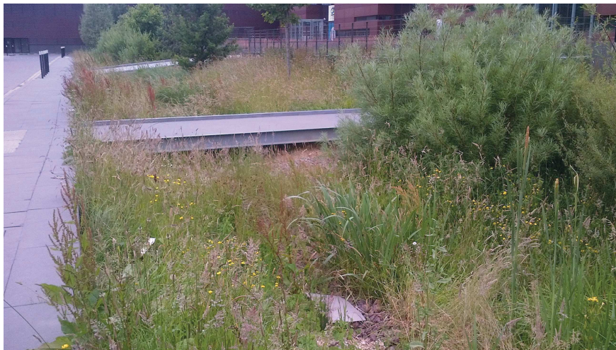
Ci-dessous évocation d'une noue végétalisée avec ses trois strates végétales (quartier La Courrouze, agglomération de Rennes).
