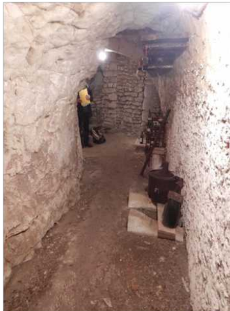
Figure 9 : Exemple d'une cavité d'extension limitée (source : Ineris)
