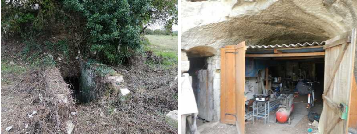
Figure 8 : Les accès aux cavités d'extension limitée (source : Ineris)
