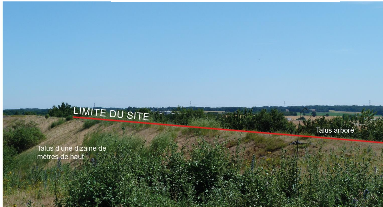
Vue depuis le haut du talus vers le Sud-Ouest
