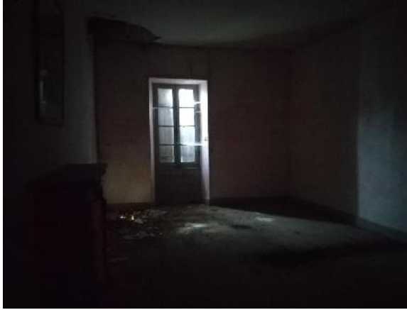
Pièce de la grange du château des Escorcières où gîte une colonie de Petit Rhinolophe (n°4).
