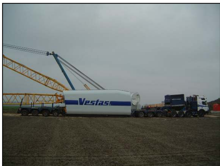
Photographie 7 : Transport de la nacelle
