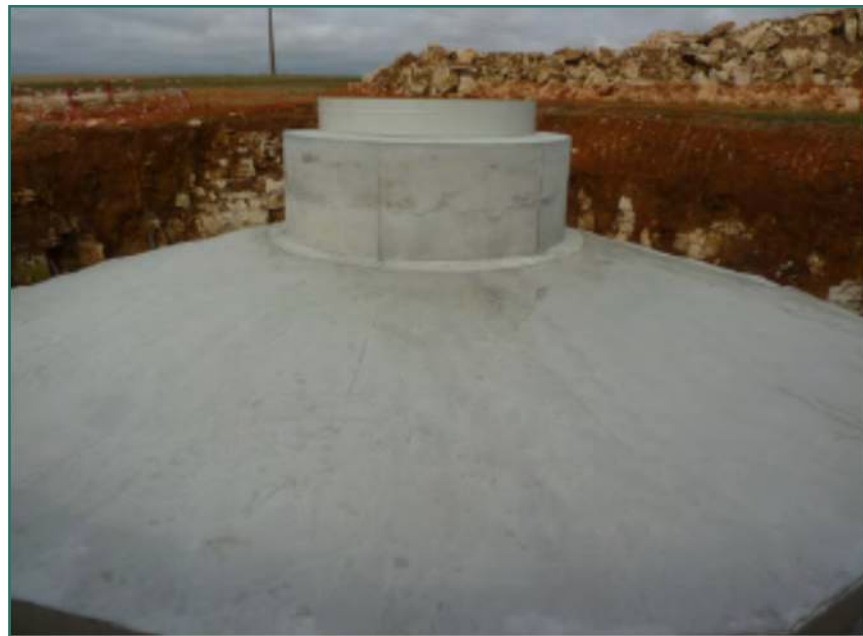
Photographie 5 : Fondation après coulage béton
