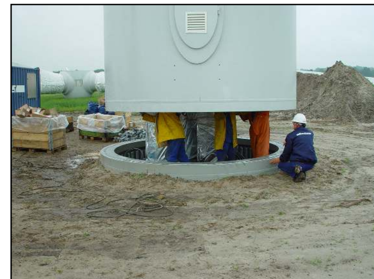
Photographie 9 : Montage du mât sur la fondation
