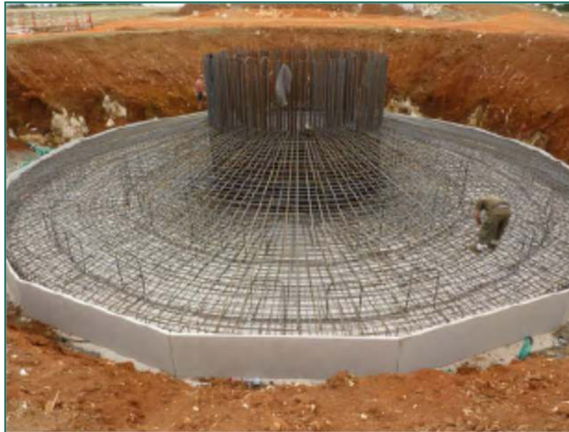
Photographie 4 : Ferrailage du massif
