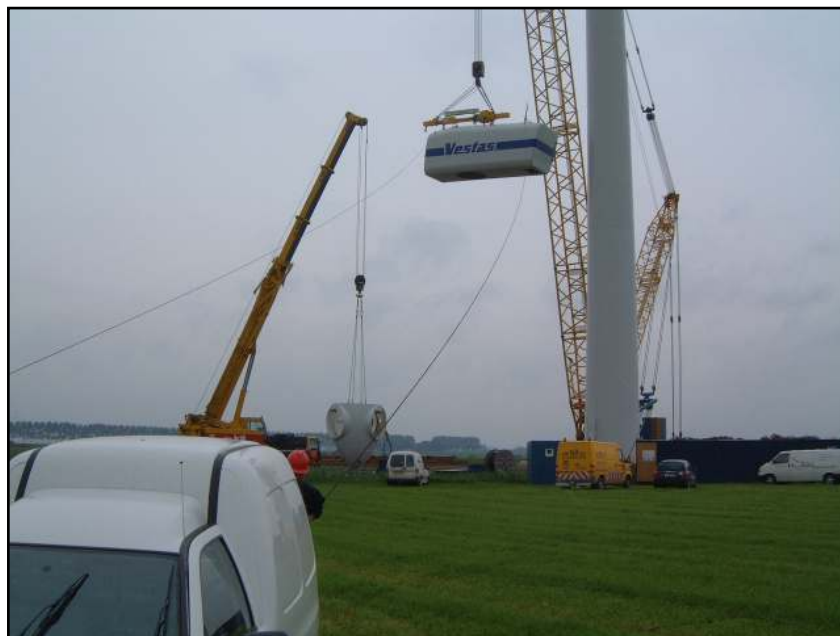
Photographie 11 : Montage de la nacelle
