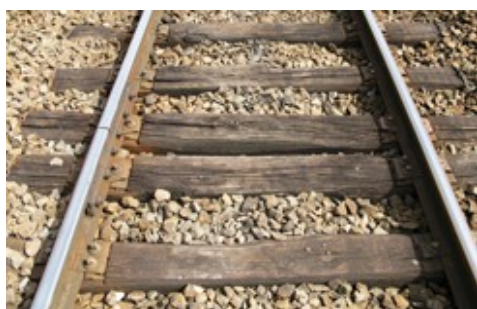
Rails courts sur traverses bois
