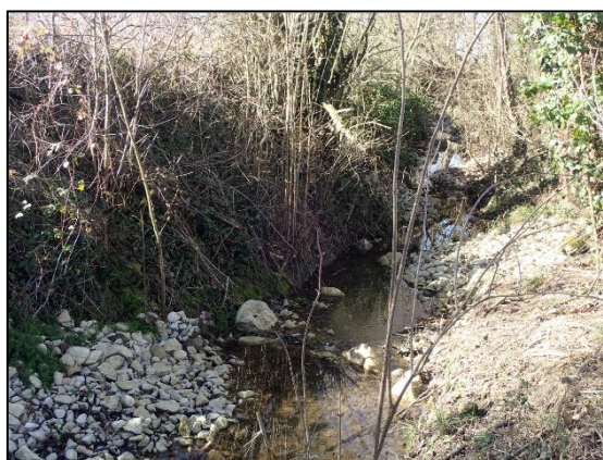
Localisation des opérations de restauration morphologique de la Veude à Thuré (secteur avec présence avérée d'écrevisse à pattes blanches) et photographies suite aux travaux au droit des lieux-dits "Toulifault" (en haut) et "Follet" (en bas)
