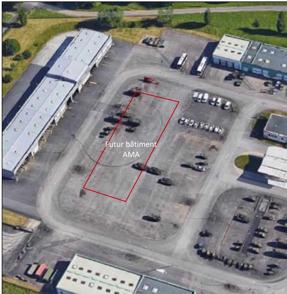
Figure 14 : Implantation du bâtiment AMA au sein de la zone Sud du RICM
