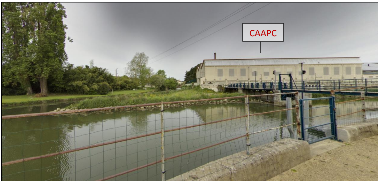
Figure 16 : Vue sur le CAAPC depuis le Jardin du Directeur (Google, mai 2016)
