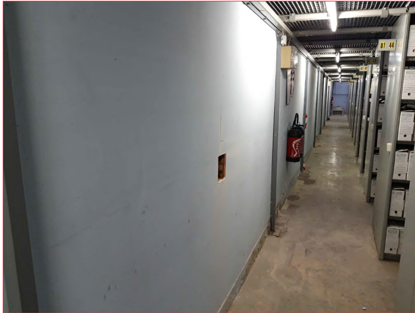
Mur D132 Nord
