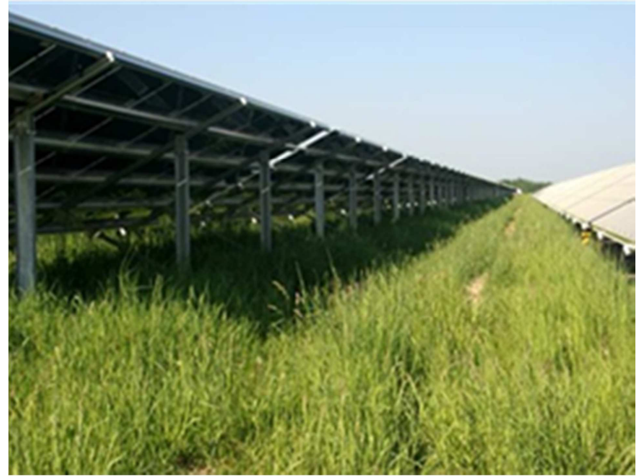
Vue sur les structures métallique
