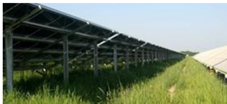
Photo 46 : Vue sur les structures métalliques
