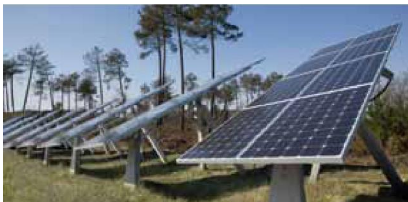
Photo 3 : Des suiveurs à rotation mono-axiale
