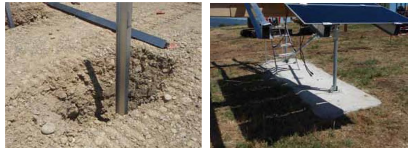
Photo 5 : Fondation avec pieux acier (à gauche) et fondation avec semelle béton (à droite)
