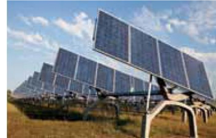
Photo 4 : Des suiveurs à rotation biaxiale
