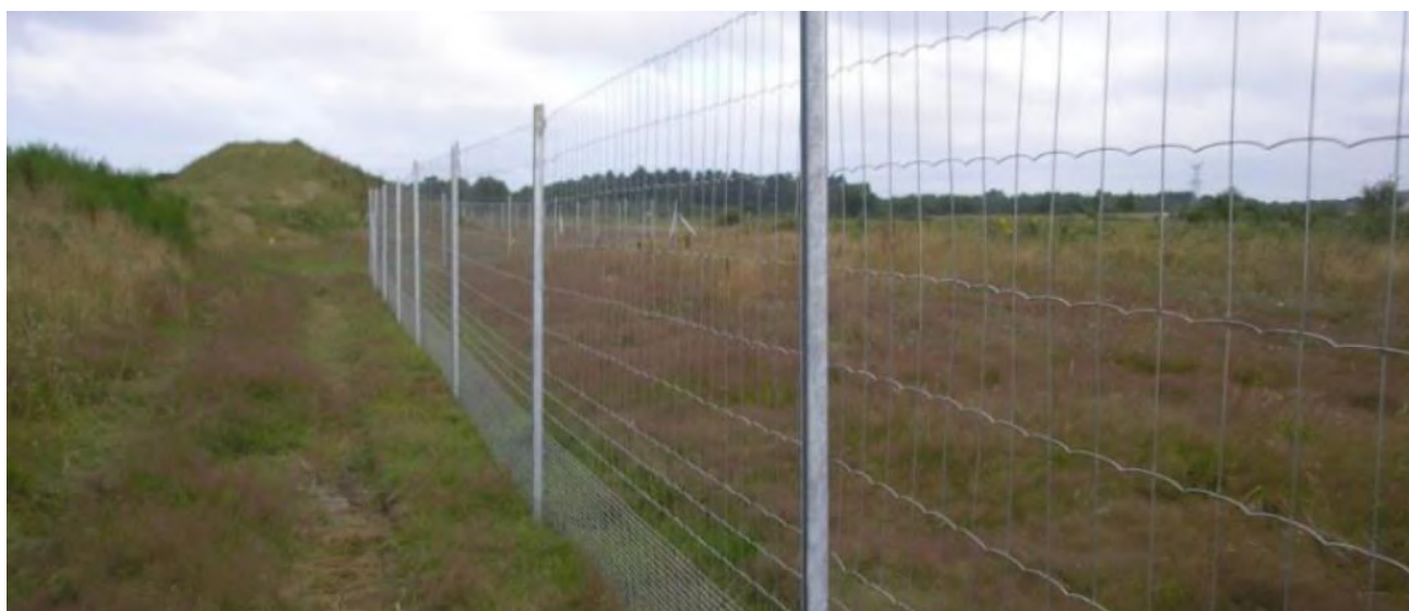
Photo 45 : Exemple de clôture (source : AEPE Gingko)
