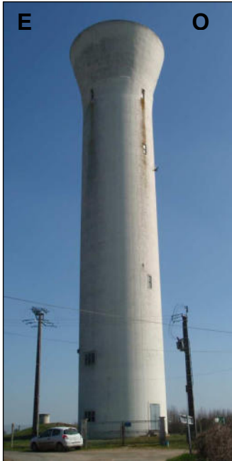
Figure 24 : château d'eau de la Preille - réservoir sur tour de 500 m 3
