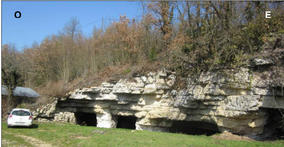
Figure 47 : anciennes carrières souterraines chemin des Pierrières (Chiré-en-Montreuil)
