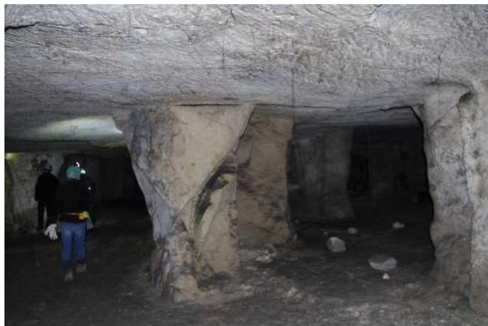
*Figure 6 : Exemple d'exploitation par chambres et piliers abandonnés (source : Ineris)*
