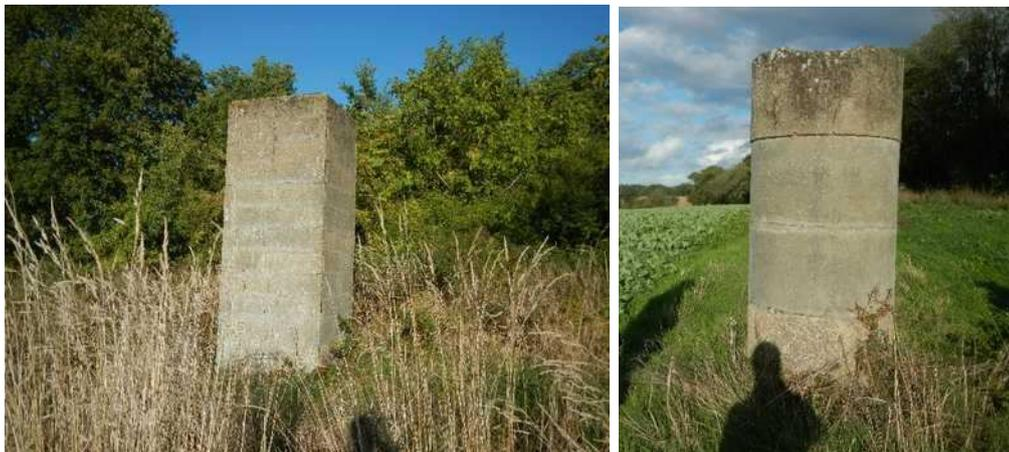
*Figure 7 : Photos de cheminées d'aération (source : Ineris)*
