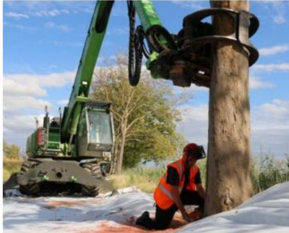
Photo 40 : Abattage assisté d'une pelle mécanique avec pince pour ralentir la chute
