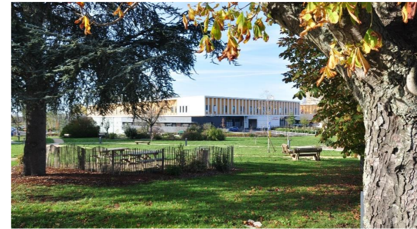
Centre hospitalier de la Milétrie – Source TAUW
