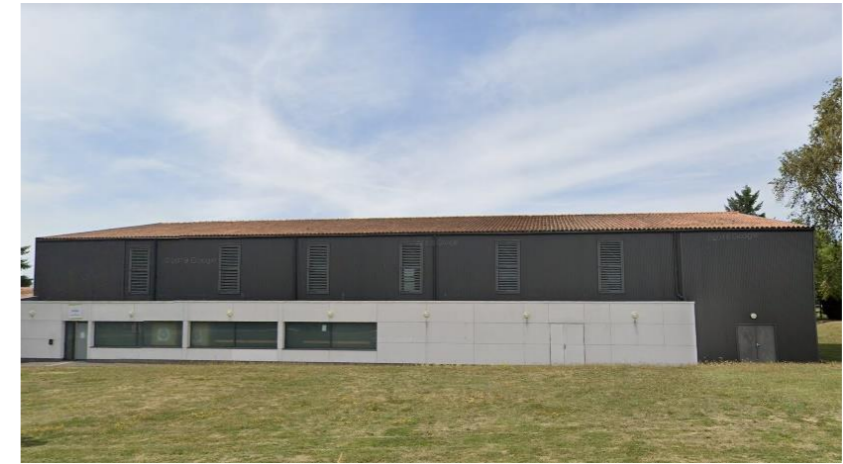
Gymnase de Mignaloux-Beauvoir – Source TAUW
