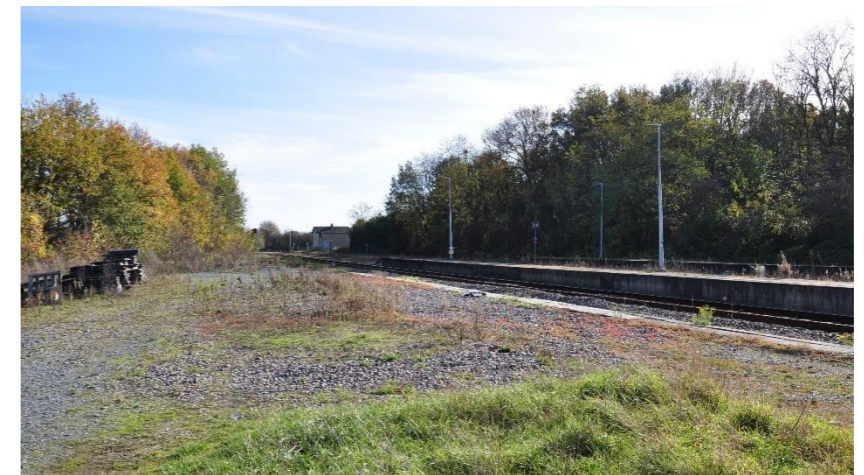
Le réseau ferroviaire – Gare de Mignaloux-Nouaillé – Source TAUW
