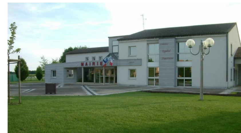
Mairie de Mignaloux-Beauvoir – Source TAUW
