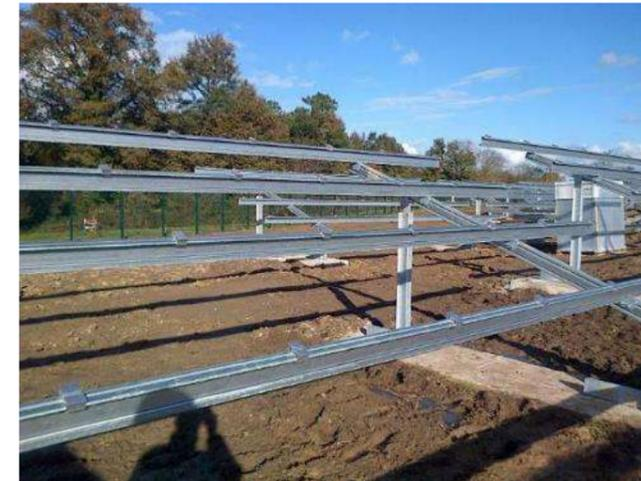
Fig. 24. Exemple de chantier de construction – Pose des structures
