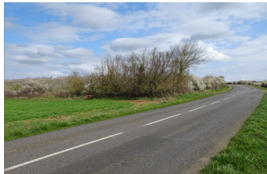
Photographie de l'état initial
