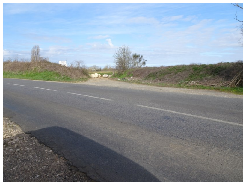
Photographie de l'état initial
