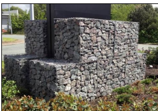
Figure 12 : Exemple de muret en gabion (Source : TCS Geotechnics)
