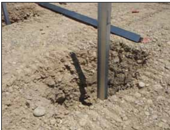
Figure 10 : Types de fondation - pieux battus (Source : Guide MEDDTL 2011 – NCA, 2015)
