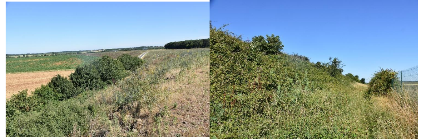
Vue du talus et de la haie à l'ouest Photo : M. PERRINET - Symbiose Environnement 08/07/2020
