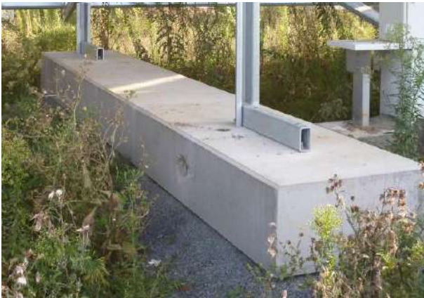
Semelles en béton
