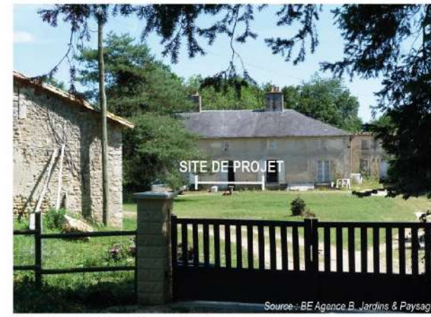
2bis. Façade du château (IMH)
