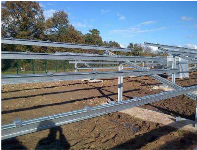
Fig. 25. Exemple de chantier de construction – Pose des structures
