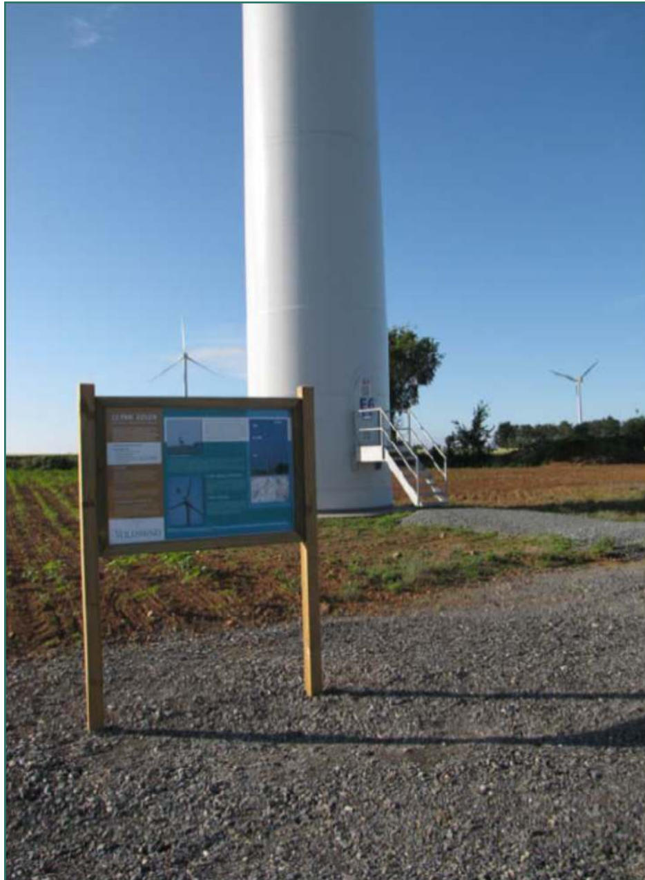
Photographie 17 : Exemple de panneau d'information – Parc éolien de Saint-Martin-Lès-Melle (79)
