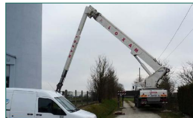
Photographie 15 : Installation d'un réémetteur sur un château d'eau.
